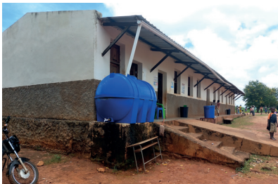
Die renovierte Schule von Lepa.
